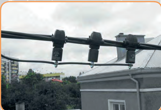
Рисунок 46 – Ограничители перенапряжения ЕТІТЕС А установленные на воздушной линии
